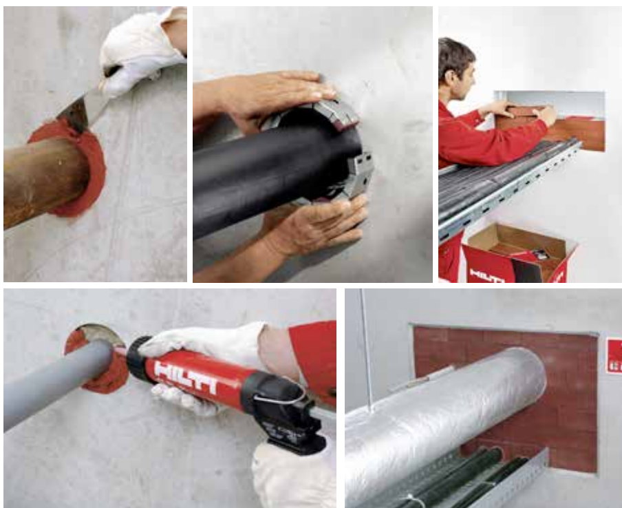
Figura 26 – Aplicação de selagens corta-fogo e fumaça
